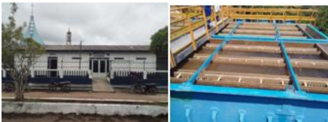
Figura 26- Companhia de Saneamento do Amazonas-COSAMA-Benjamin Constant (Estação de Tratamento de água)
