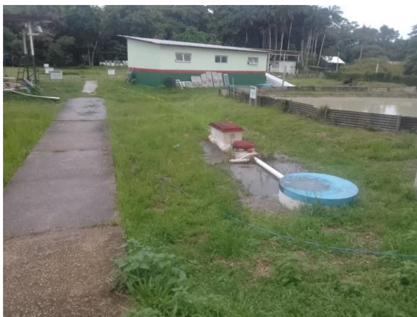
Figura 28- Viveiro escavado utilizado para manutenção de quelônios e mini Estação de Tratamento de esgoto. (Unidade Experimental e Produção - UEP do IFAM em Tabatinga-AM).
