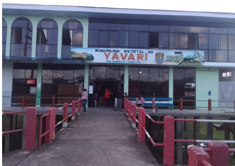
Figura 20- Sede administrativa da Municipalidad Distrital de Islândia de Yavari-Peru
