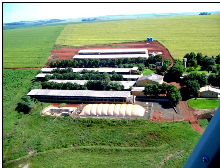
Figura 10 - Vista Aérea da Unidade Granja Colombari. Fonte: Coordenadoria de Energias Renováveis (CEB) (2009).
