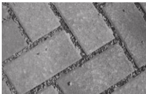
Figura 4. Pavimento com revestimento constituído por peças de concreto com juntas alargadas. Fonte: NBR 16416, 2015.
