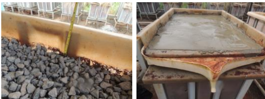
Figura 13. Montagem caixa coletora “A”, passeio público de concreto impermeável. Fonte: Própria.
