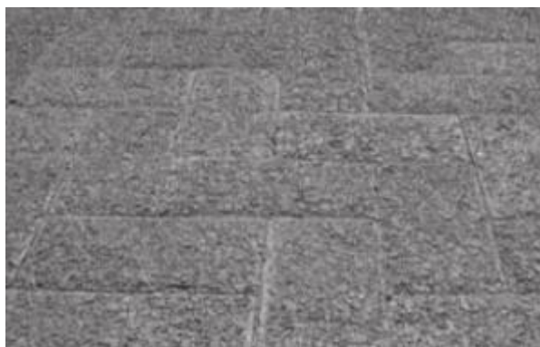
Figura 5. Pavimento com revestimento constituído por peças de concreto permeável. Fonte: NBR 16416, 2015.
