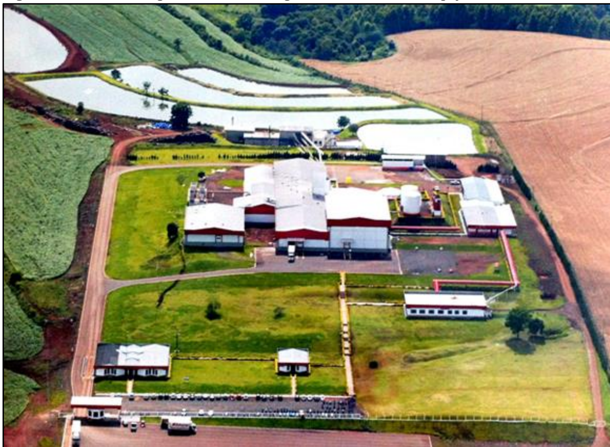
Figura 42: Unidade Frigorífica da Vibra Agroindustrial S/A em Itapejara D'Oeste
