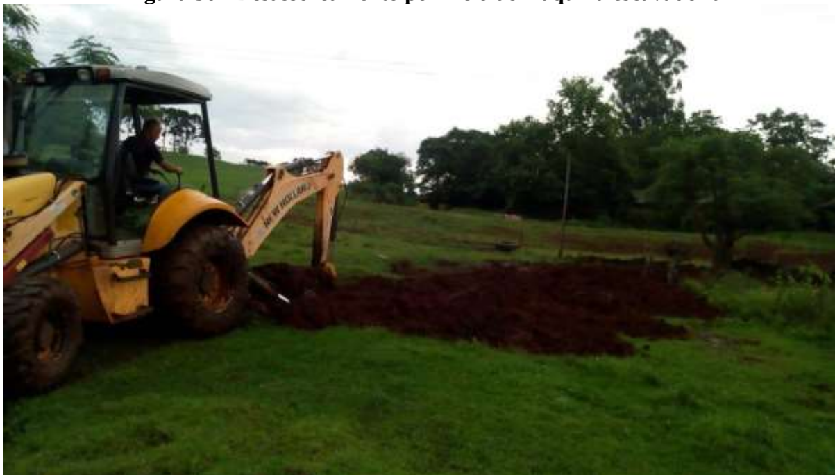
Figura 36 - Desassoreamento por meio de máquina escavadeira
