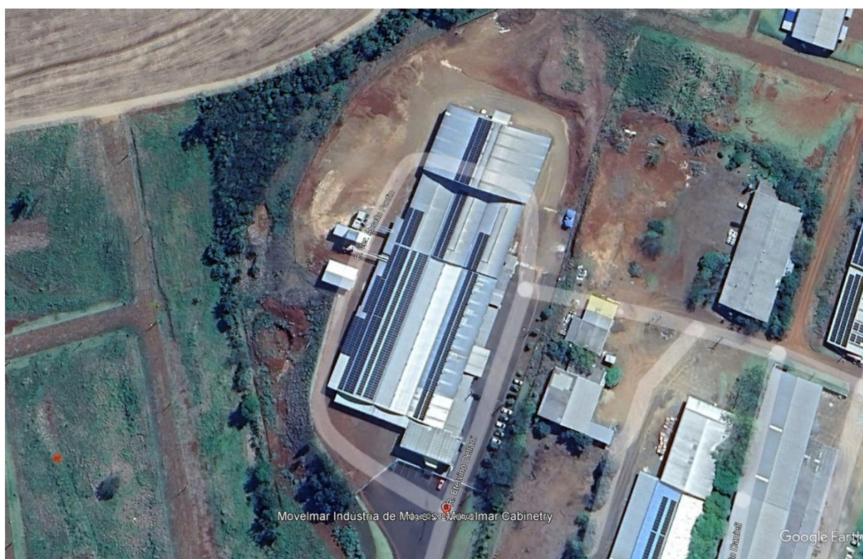
Figura 23 – Vista aérea da indústria de móveis Movelmar
