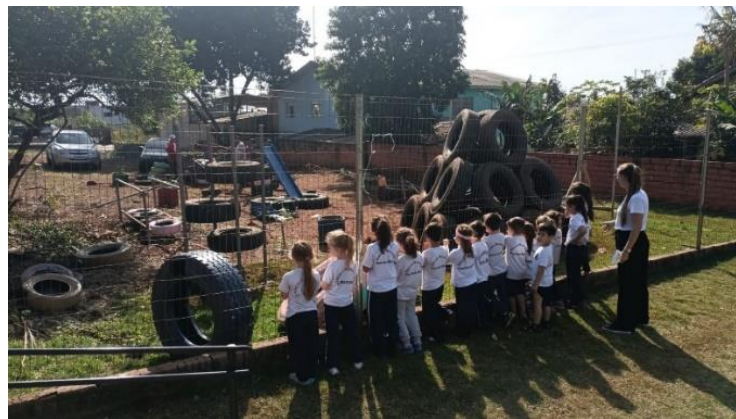
Figura 13 - Execução do parquinho de pneus
