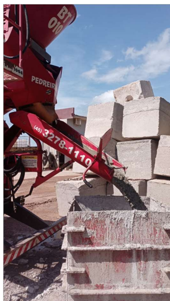
Figura 5. Disposição deste excedente de concreto na central
