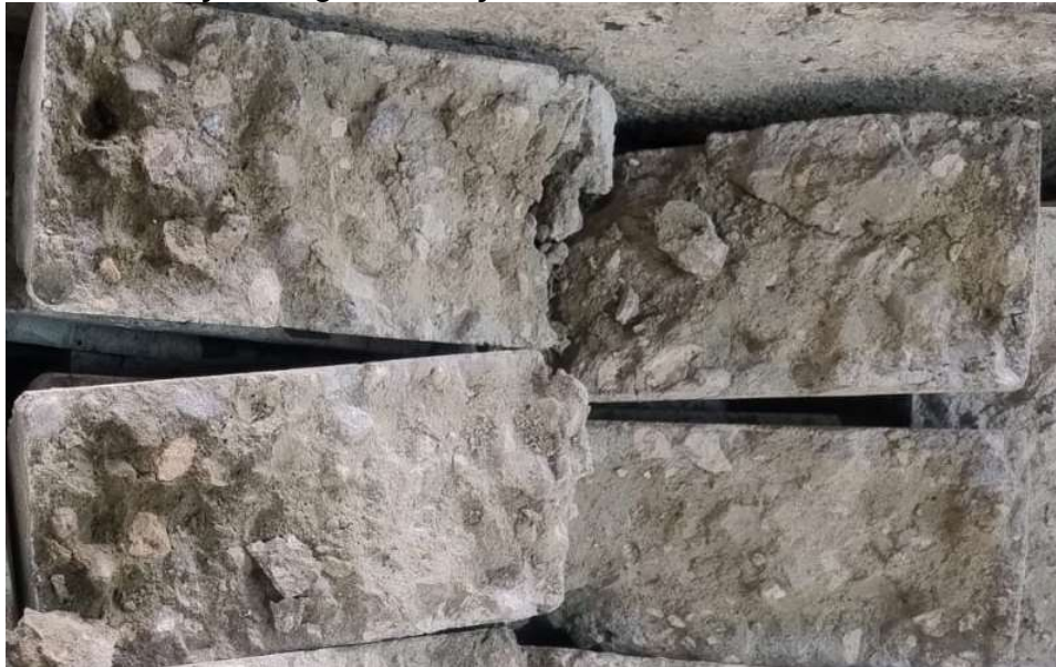
Figura 11. Presença de água no traço S506
