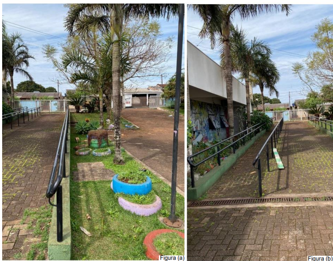
Figura 14 - Rampa PNE (a), Rampa de acesso de carros (b)
