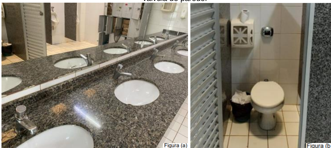
Figura 7 – Dispositivos hidráulicos (a) Torneiras Banheiro Masculino e Feminino; (b) Descarga de válvula de parede.
