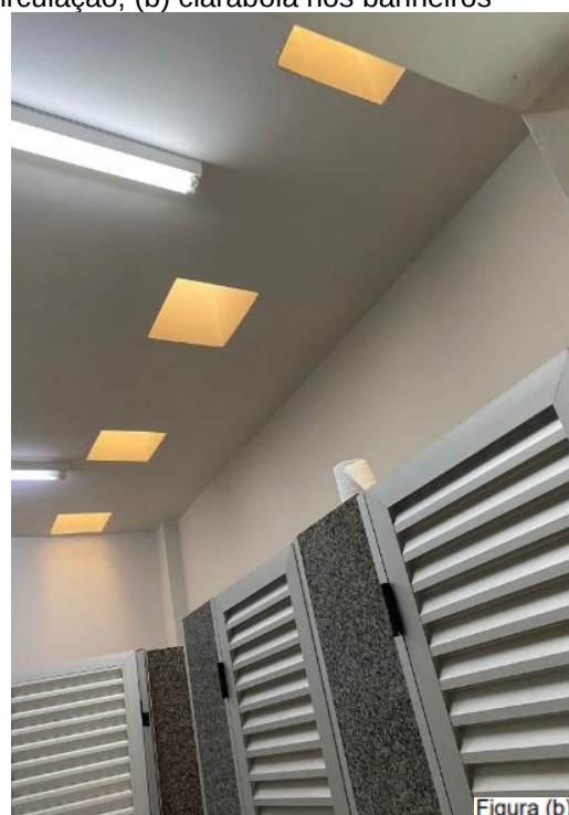
Figura 8 - Claraboia. (a) Claraboia na circulação; (b) claraboia nos banheiros
