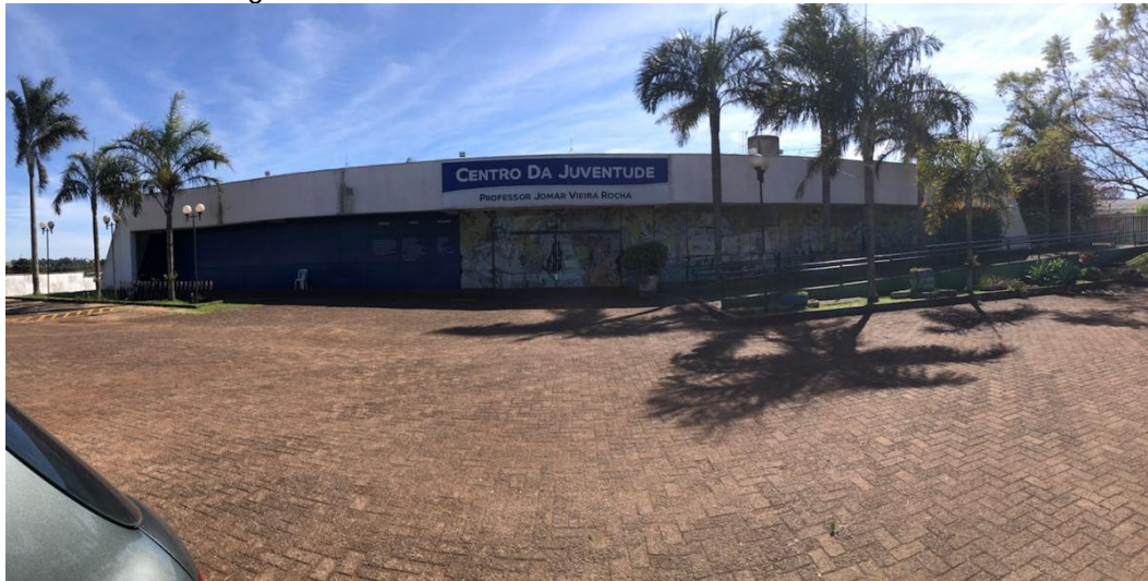
Figura 13 - Paver em toda extensão do estacionamento
