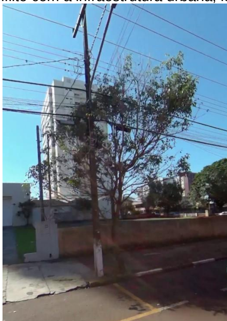
Figura 15 - Árvore em conflito com a infraestrutura urbana, localizada no bairro Centro.
