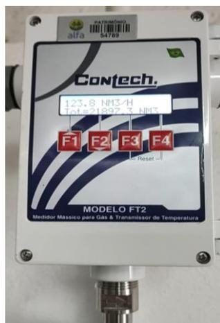
**Figura 17** - Medidor de vazão tipo thermal para gás série FT2A.
