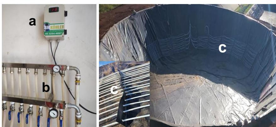
**Figura 12** - Equipamentos: a) Painel de automação da temperatura, b) Sistema de controle (T °C) entrada e saída da água quente, c) Aquecimento dentro biodigestor.
