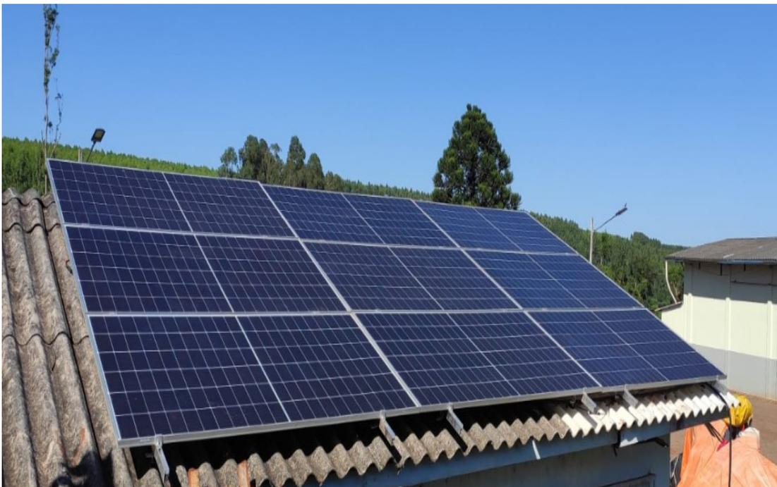
*Figura 18 - Módulos fotovoltaicos instalados no telhado do LIF*
