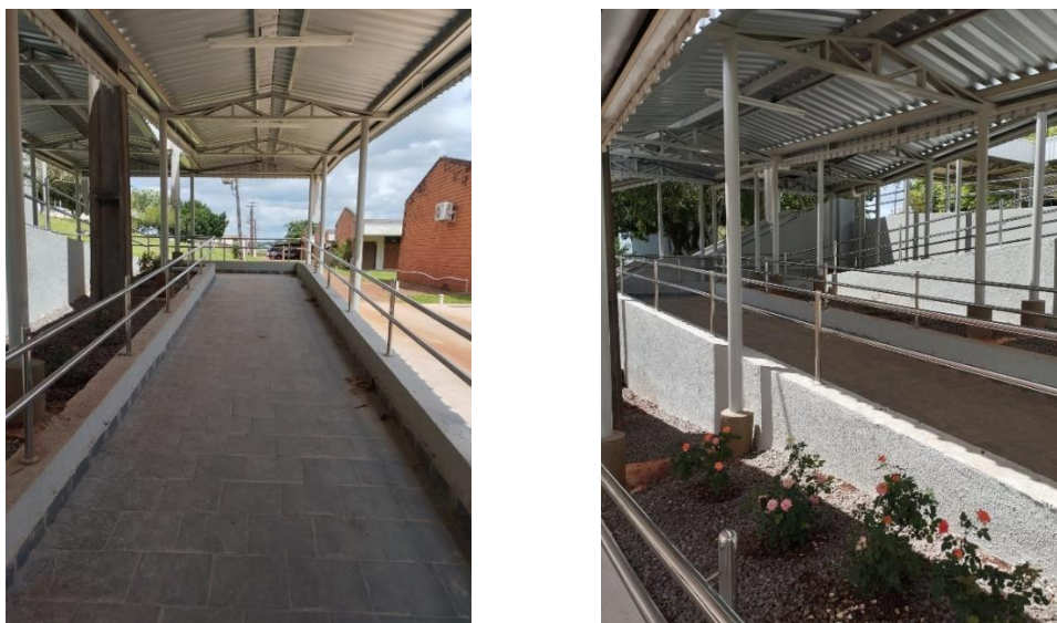
Figura 7 – Rampa com acesso às salas de aulas
