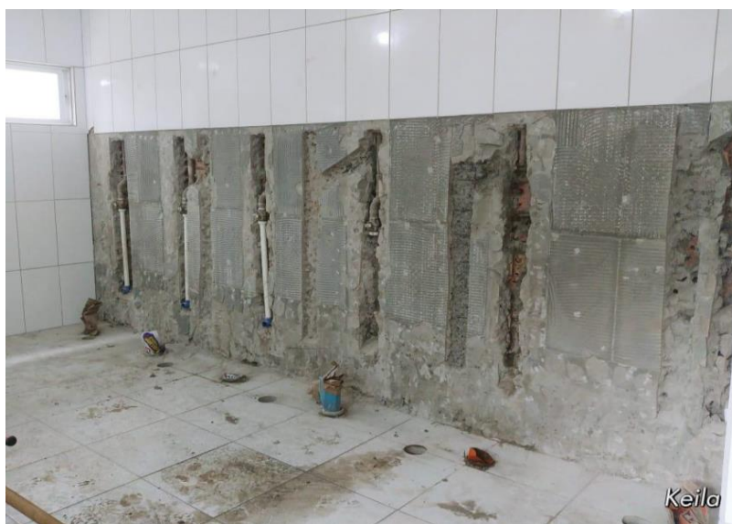
Figura 10 - Banheiro coletivo da EEB Professora Zitta Flach
