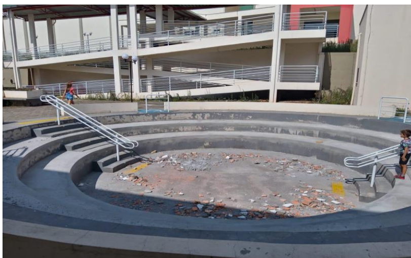
Figura 9 - Estrutura da EEB Professora Zitta Flach no Início das Aulas
