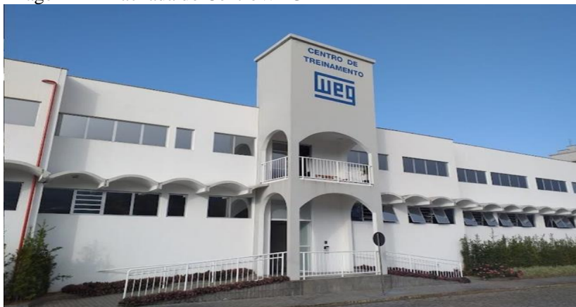
Imagem 21 - Fachada do CentroWEG
