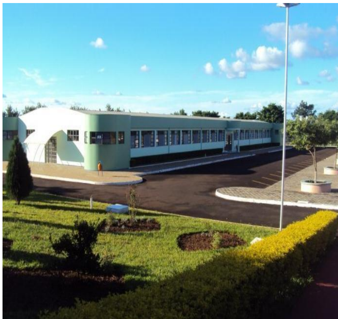
Figura 05 – Instalações do Centro de Ensino Superior de Realeza
