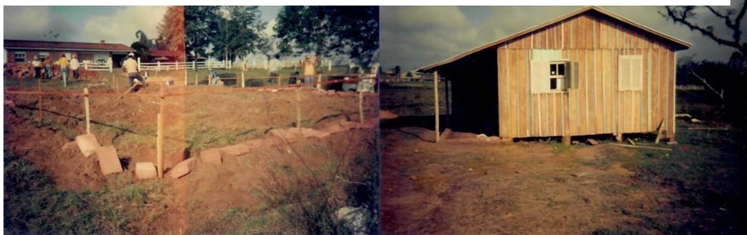
Figura 5: Construção das primeiras casas da agrovila COOPAN (1994)
