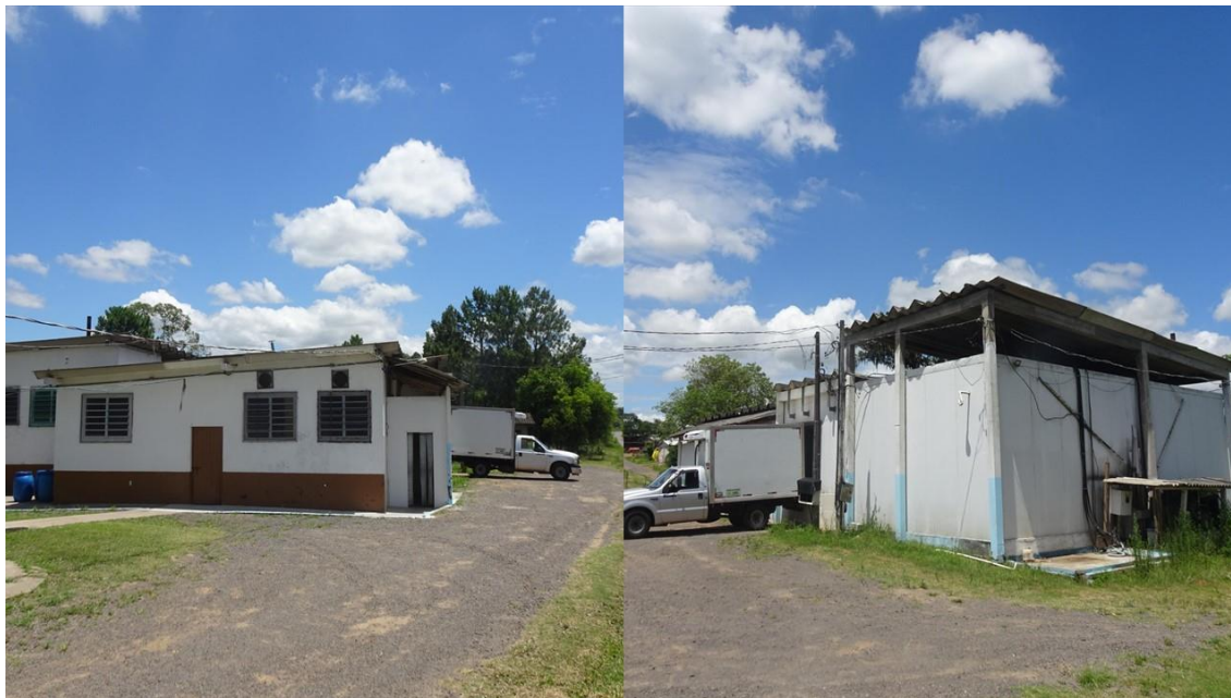
Figura 13: Estrutura do antigo frigorífico da COOPAN
