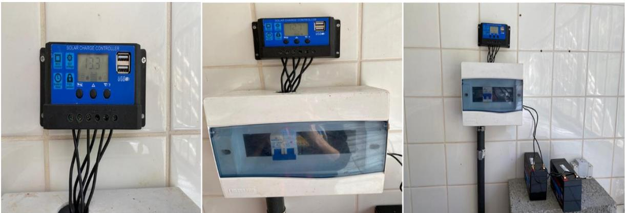
Figura 10 Instalação do controlador de carga e do kit de baterias.
