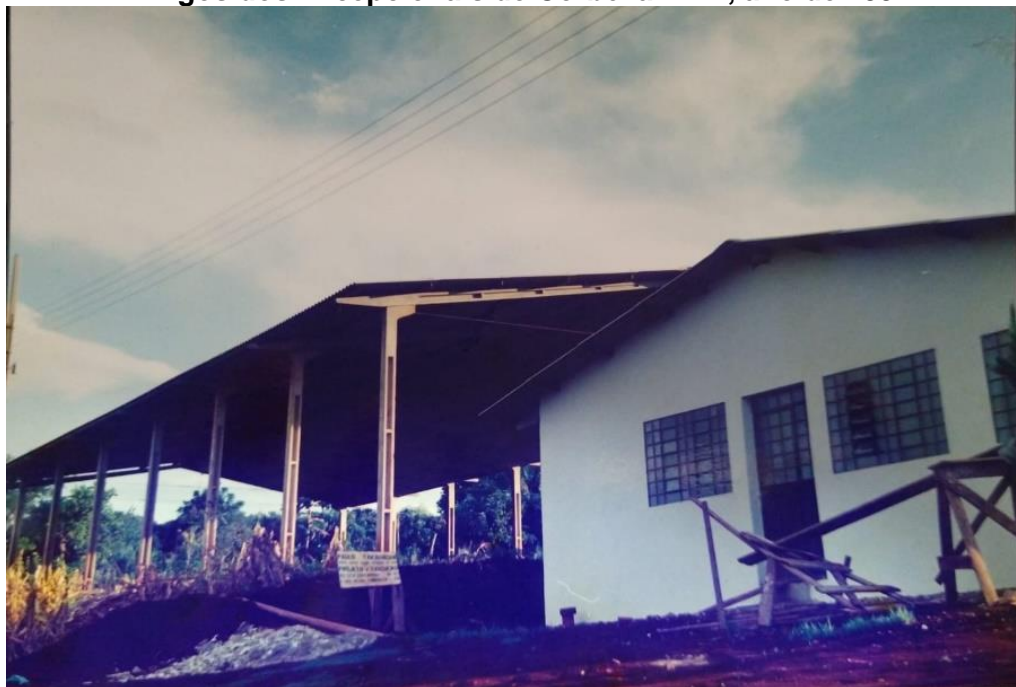
Figura 6 - Etapa final da construção da primeira estrutura da Associação de Pais e Amigos dos Excepcionais de Corbélia – PR, ano de 1992
