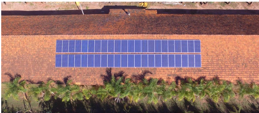
Figura 3.10 – Arranjo fotovoltaico policristalino com sombreamento em granja de aves em Iporã-PR
