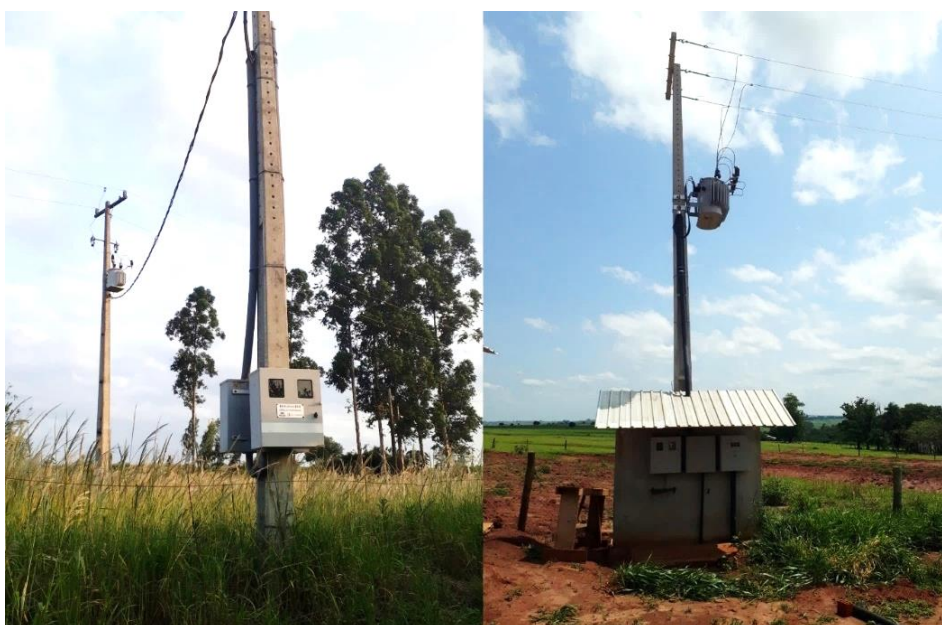
Figura 3.5 – Padrões de Entrada do tipo monofásico rural à esquerda e trifásico à direita em imóveis rurais de Iporã-PR
