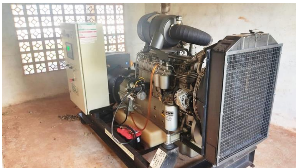
Figura 3.6 – Grupo gerador a diesel como backup elétrico emergencial de um imóvel rural de Iporã–PR
