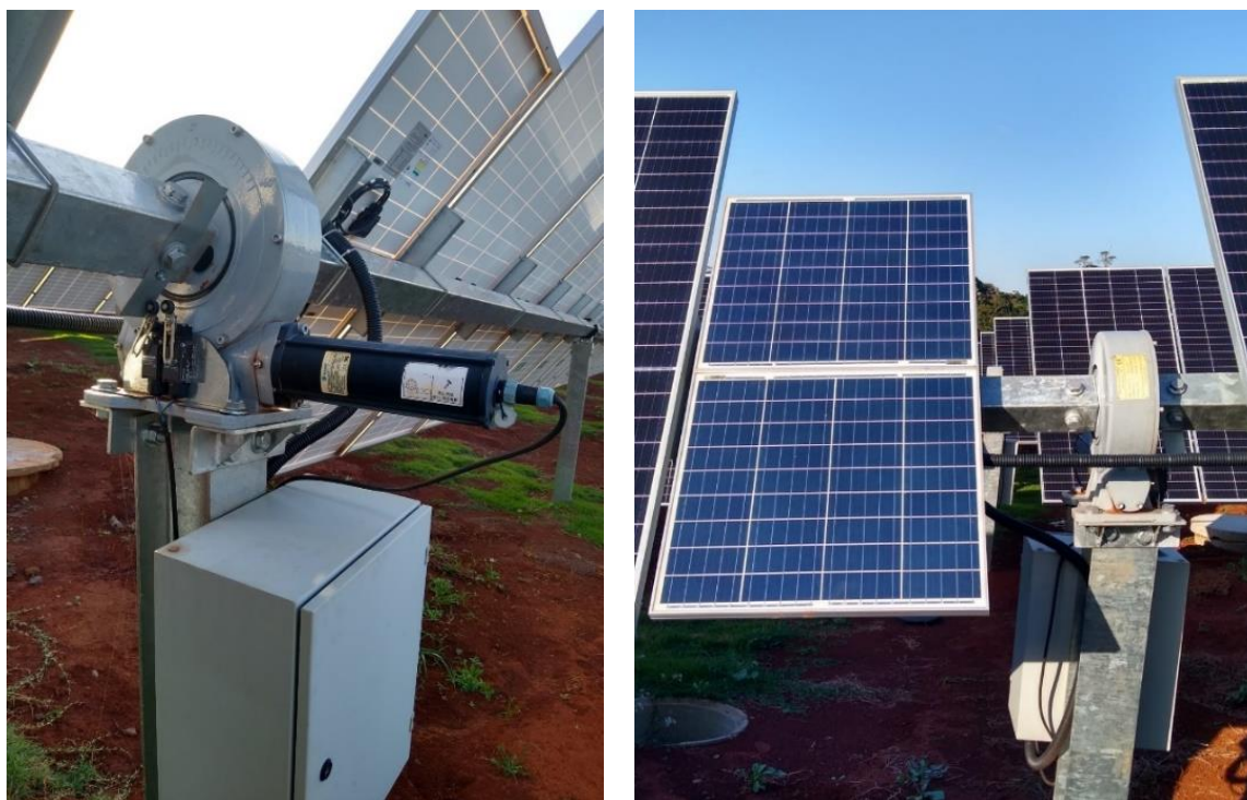
Figura 18 - Sistema rastreador: a) Motor b) Módulo para alimentação do motor Fonte: A própria autora.
