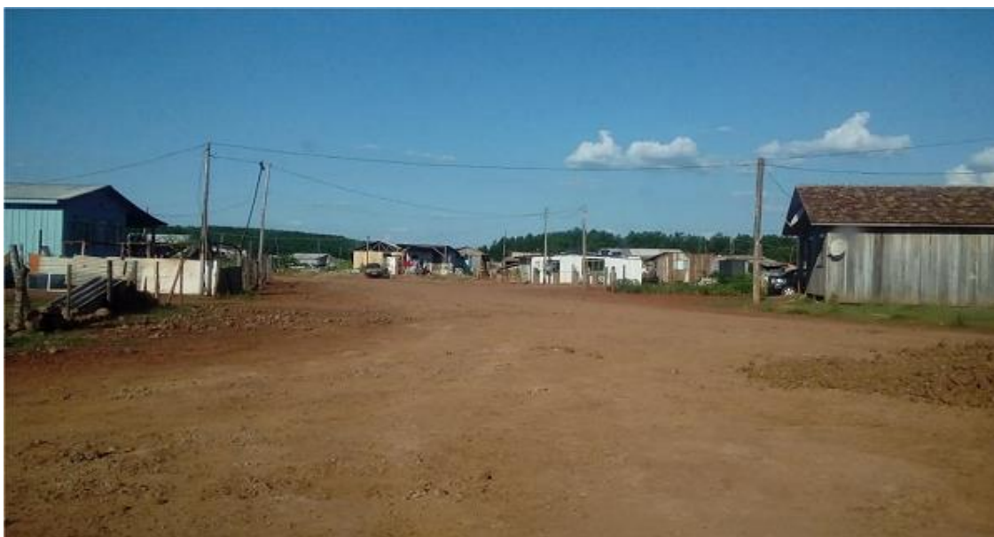
Figura 5: Área de Ocupação “Terra Nossa”.
