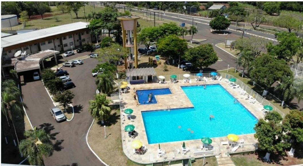
Figura 6 – infraestrutura da Empresa C
