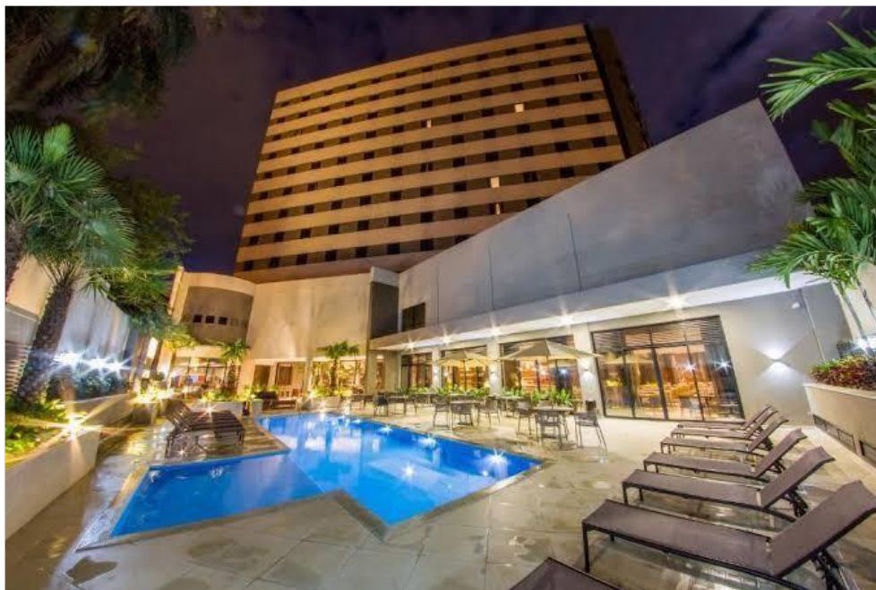
Figura 5 – Infraestrutura da Empresa B
