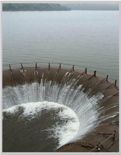
Figura 21 - Vertedouro Lago Municipal
