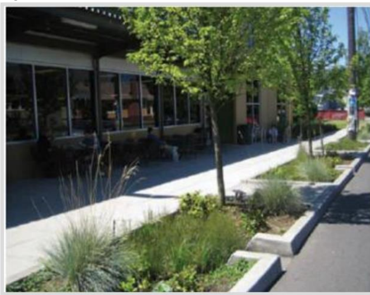
Figura 1 - Canteiros Pluviais Juntos do NewSeasons Market, Portland, Oregon/EUA
