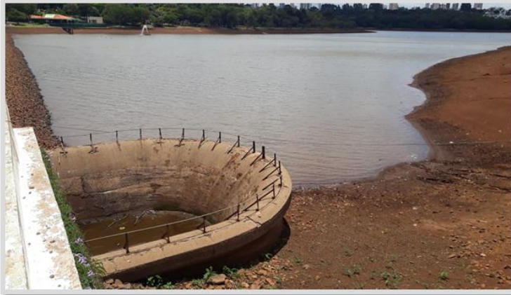
Figura 17 - Ponto de coleta próximo ao vertedouro
