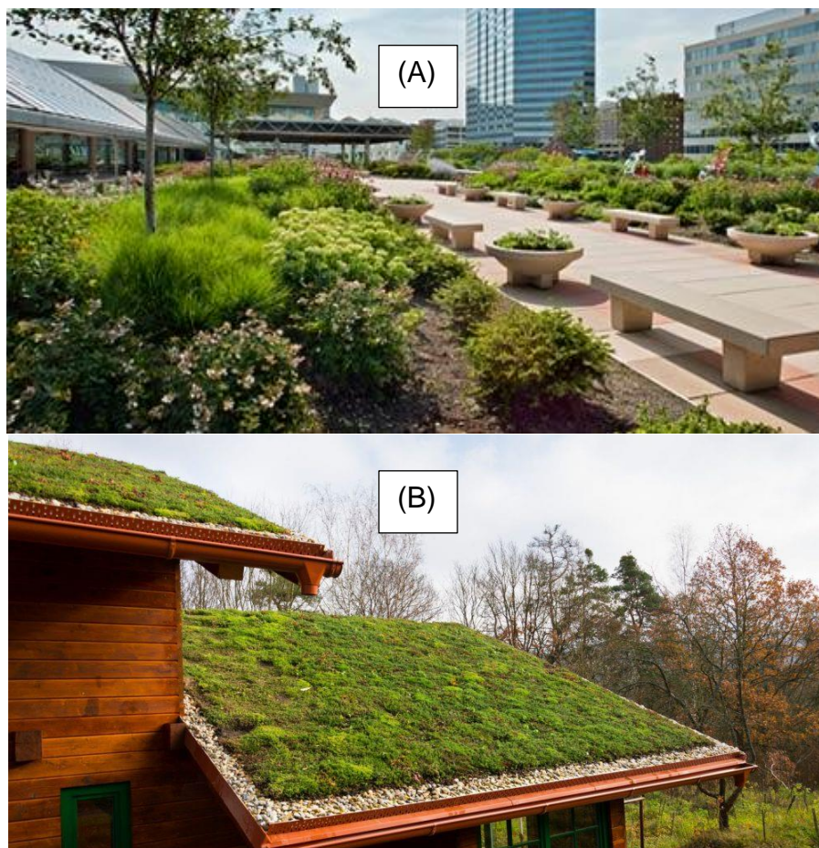
Figura 4: Exemplos de telhado verde intensivo (A) e extensivo (B).
