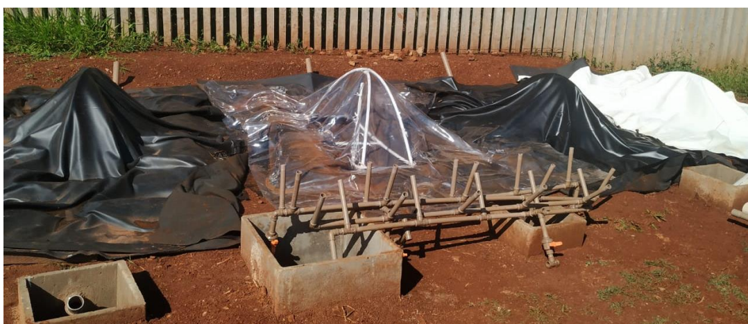
Figura 10: Instalação dos biodigestores no local.
