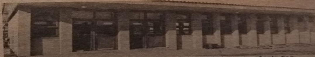
Nestas dependências do Centro Comunitário, será instalada uma agência bancária.
