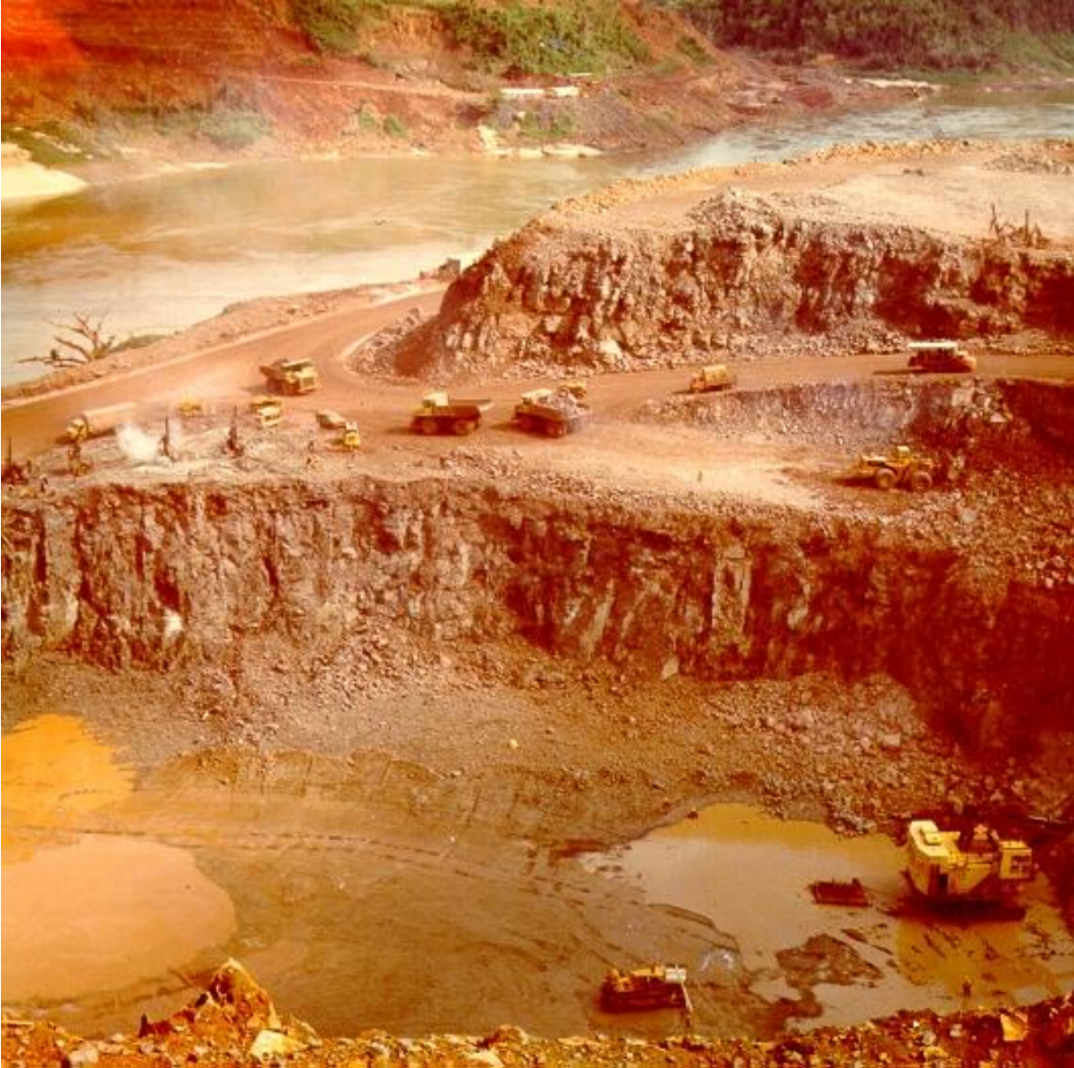
Foto 1 – Construção da Usina Hidrelétrica de Itaipu em 1977
