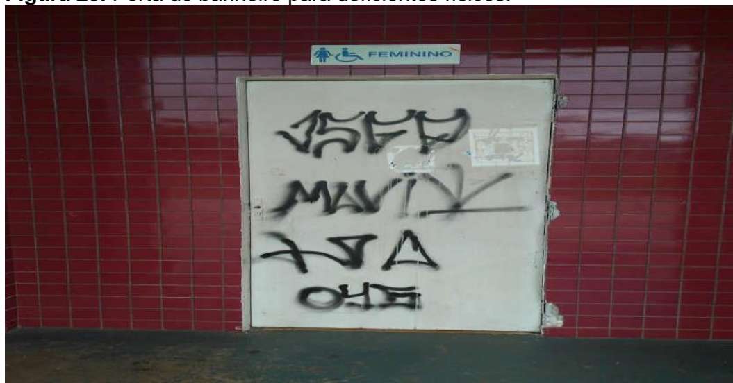
Figura 23. Porta do banheiro para deficientes físicos.
