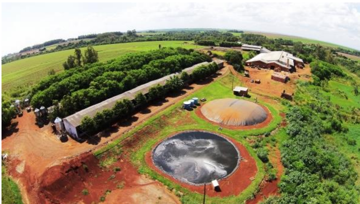
Figura 9: Imagem ilustrativa da Cerâmica Stein, granjas de suínos e biodigestor.
