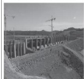
As Obras Civis do Poço da Turbina 01 estão em estágio avançado, a área de montagem está praticamente concluída e as demais estruturas da Casa de Força seguem dentro do ritmo projetado. Um exemplo de planejamento, engenharia moderna e dedicação diária de todos os colaboradores.
