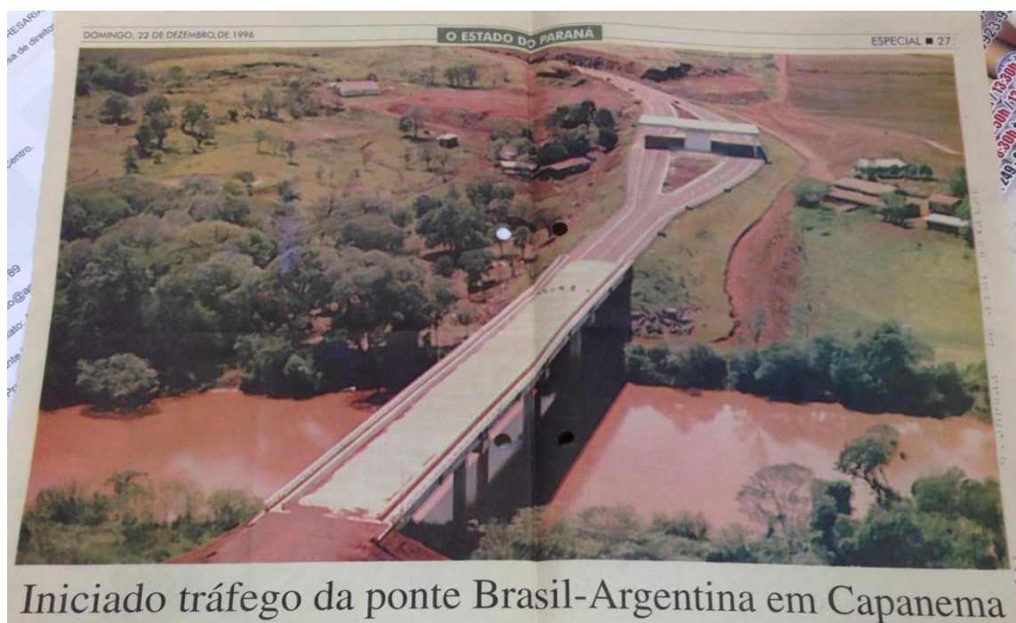
Figura 15: Iniciado tráfego da ponte Brasil-Argentina em Capanema
