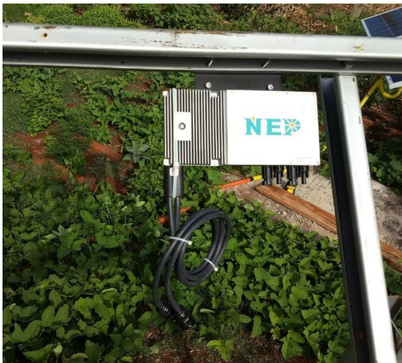
Figura 31 – Fixação do Microinversor na Estrutura.
