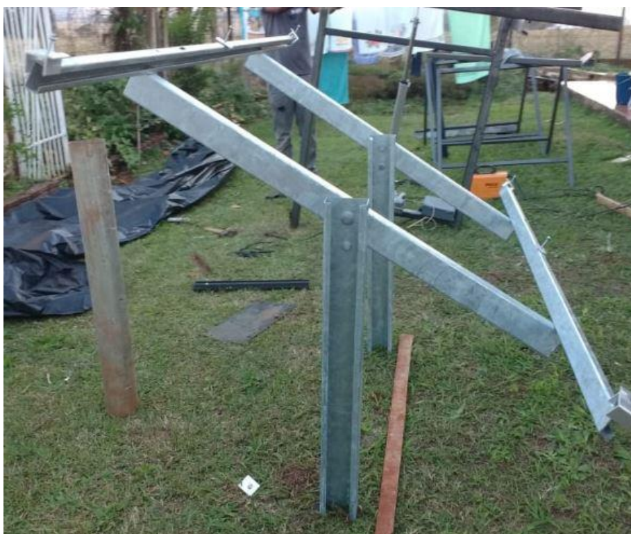
Figura 28 – Montagem das Estruturas para Sistemas Fotovoltaicos Fixo e Móvel.
