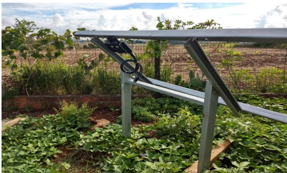
Figura 29 – Instalação das Estruturas no Local do Experimento.
