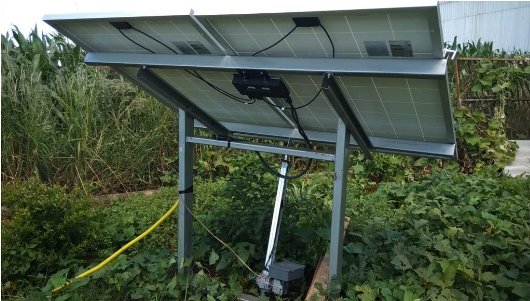
Figura 32 – Fixação dos Painéis Fotovoltaicos na Estrutura de Um Eixo.
