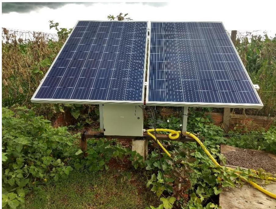
Figura 34 – Instalação do Quadro Elétrico na Estrutura Fixa.
