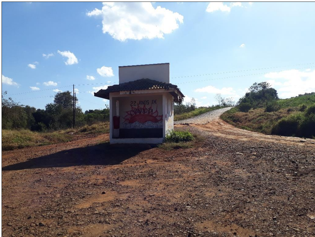
Figura 9 - Entrada do Assentamento Ireno Alves dos Santos
