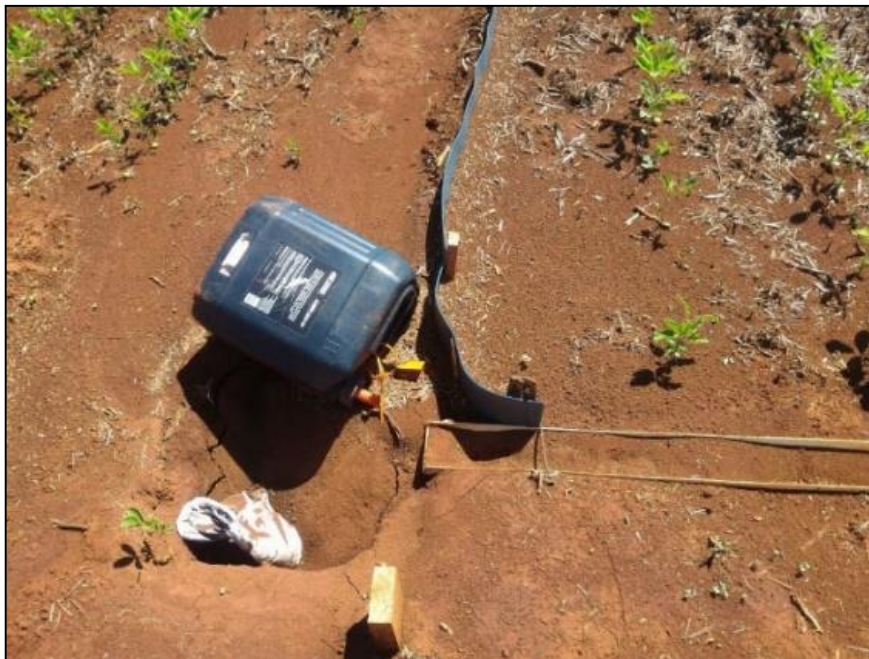
Figura 9. Calha entupida em dia de precipitação elevada.
