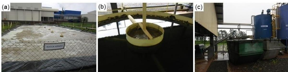
Figura 2 – Geração do lodo secundário de laticínio: (a) lagoa aerada com sistema de lodos ativados, (b) separação de fases em decantador e (c) remoção de umidade em tanques adensadores (a direita) e desaguamento em centrífuga (a esquerda)
