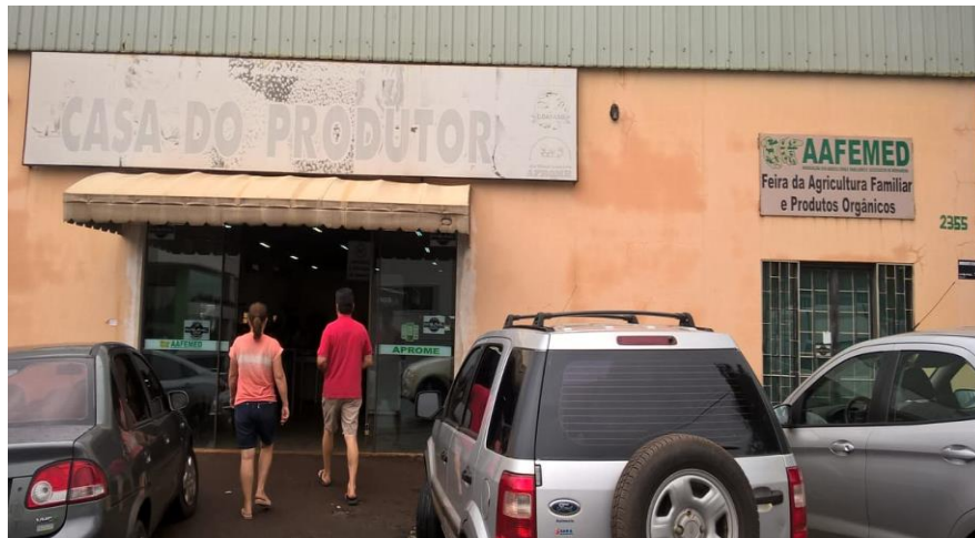
Figura 3 Casa do Produtor, Medianeira
