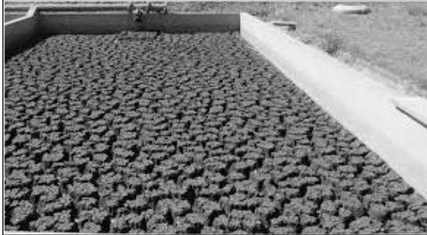
Figura 3.2 - Leito de secagem do lodo de esgoto sanitário doméstico.
