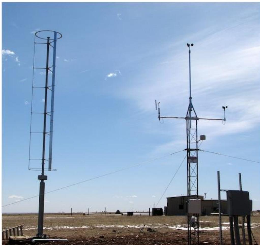
**Figura 2:** Aerogerador de eixo vertical
