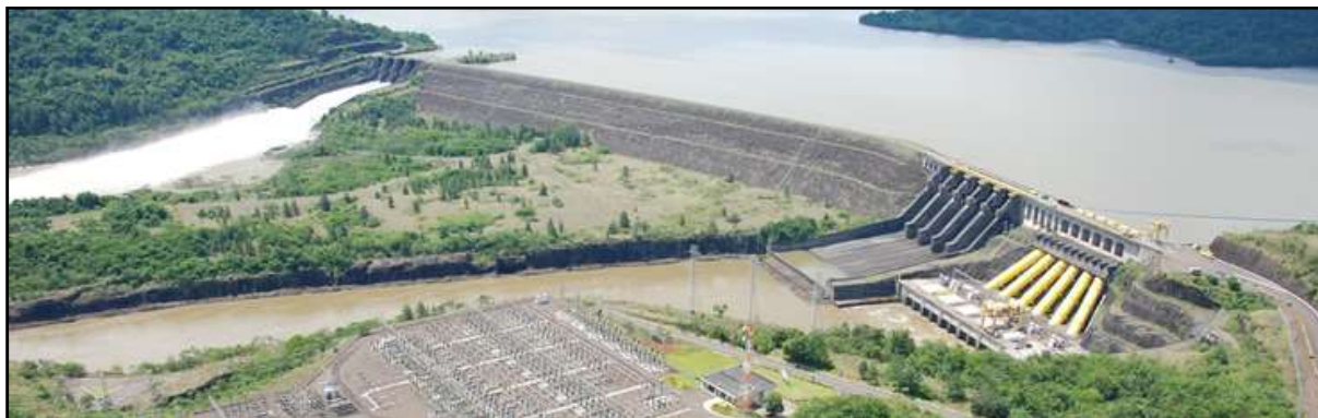
Figura 13 – Vista panorâmica da UHE Salto Osório.
