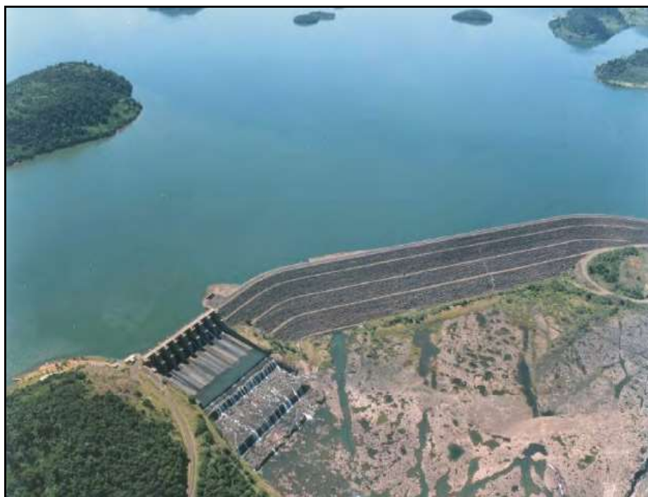
Figura 16 – Vista panorâmica da UHE Salto Santiago. Fotografia: ECSA (2002b, p. 83).
