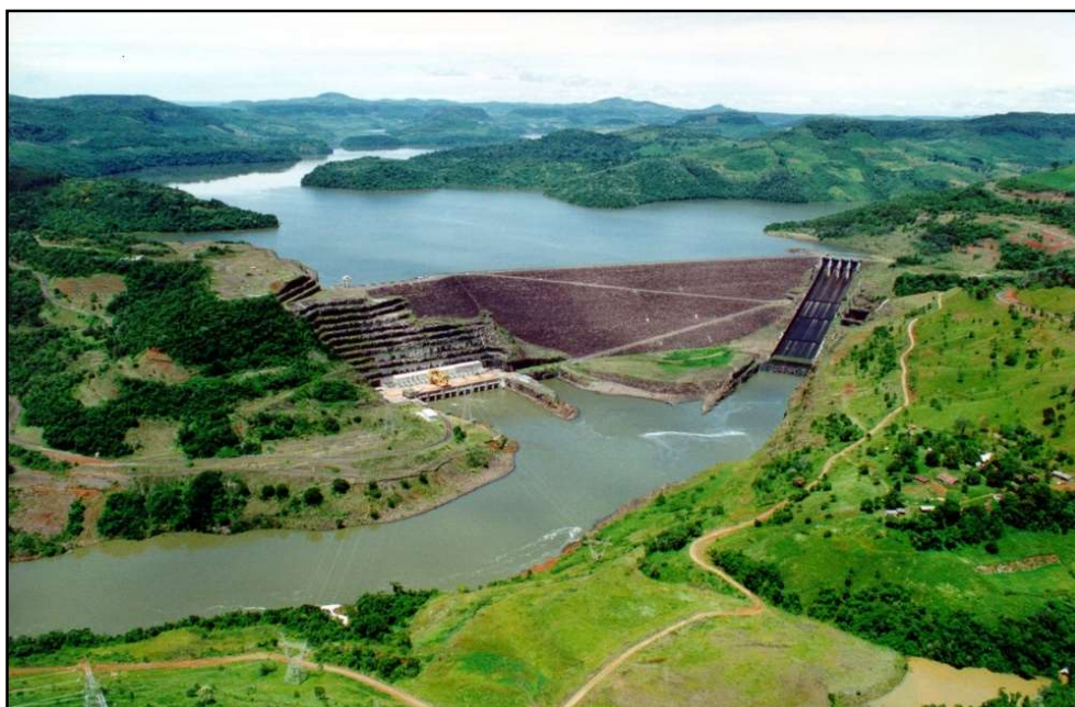
Figura 14 – Vista panorâmica da UHE Foz do Areia.
