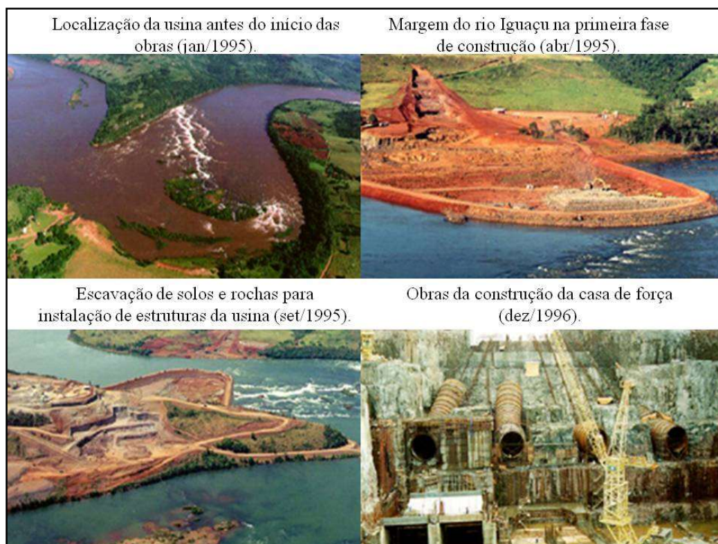
Figura 21 – Fotografias sequenciais da construção da UHE Salto Caxias. Fotografias: Borba (2016). Adaptada pelo autor (2017).
