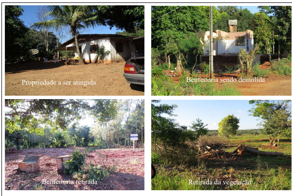
Figura 40 – Benfeitorias atingidas que estão sendo demolidas e retiradas (2018).
