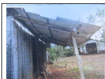
Figura 3 – Residência e aviário antes do desmanche.
