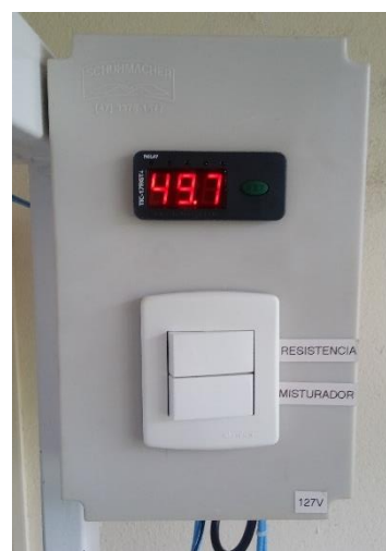
Figura 5 Painel de controle do Reator de Biodiesel
