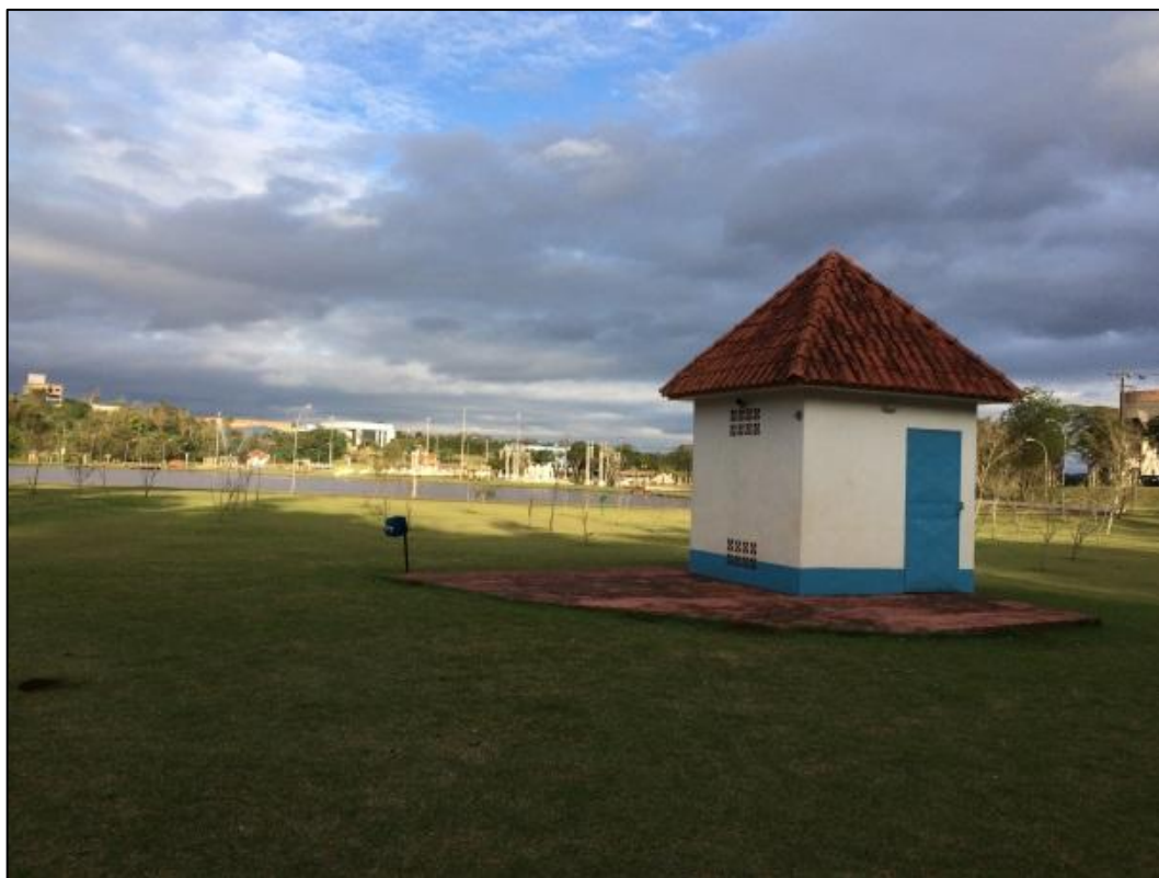
Figura 45: Captação de água no parque na Área de Proteção Ambiental (APA 03)
