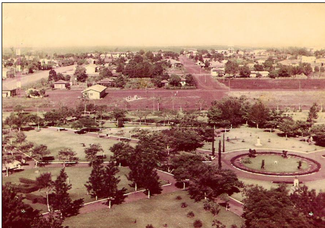
Figura 29: Vista Aérea Praça Willy Barth (1969)
