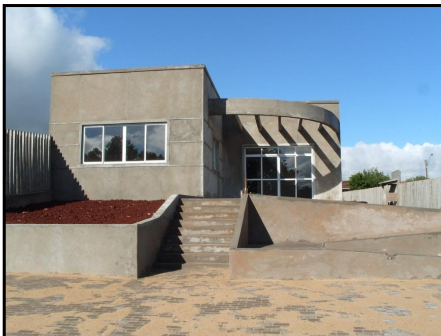
Figura 38 – Construção da Sede do CRAS Santa Cruz
