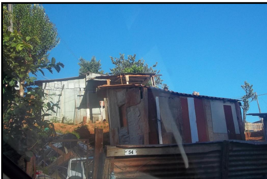
Figura 30 – Residências abaixo da Linha do Asfalto do Bairro XIV de Novembro
