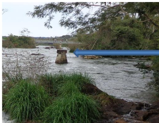
Figura 51: Estrutura de concreto que fazia parte da Passarela do Salto San Martín (ARG) (Foto da autora)
