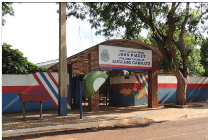
Figura 5 - Infraestrutura: Escola do Distrito de São Camilo, Palotina/PR
