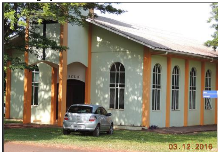
Figura 4 - Infraestrutura: Igreja do Distrito de São Camilo, Palotina/ PR.
