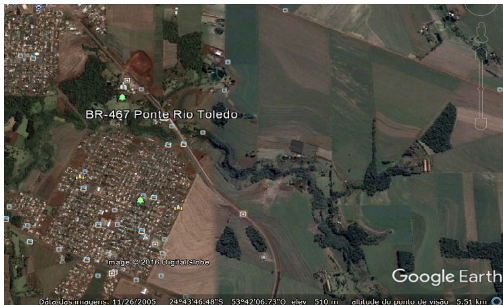
Figura 30 - Ponte do Rio Toledo na BR 467 no ano de 2005.
