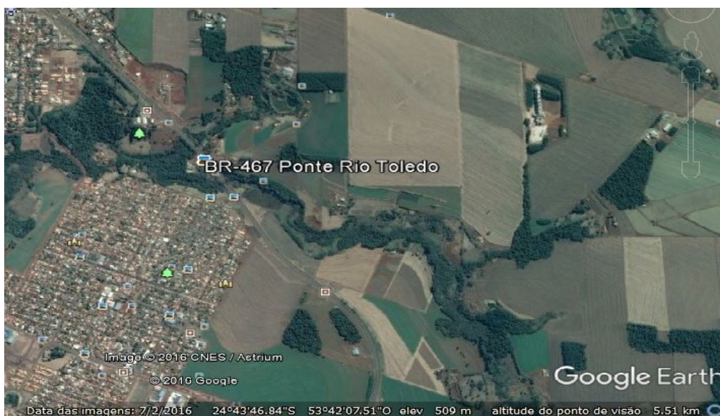
Figura 31 - Ponte do Rio Toledo na BR 467 no ano de 2016.
