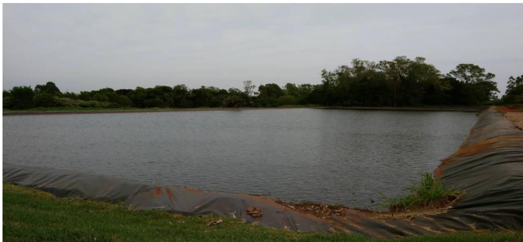
Figura 5 Lagoa de evaporação de lixiviado do aterro sanitário de Cascavel - PR.
