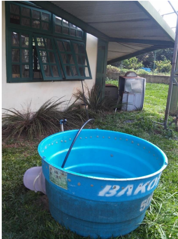
Figura 11: Caixa d'água do sistema de irrigação. Fonte: (Autor, 2016).
