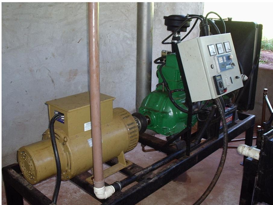
**Figura 5** - Conjunto motor-gerador utilizado na propriedade 2, operando com biogás da suinocultura.
