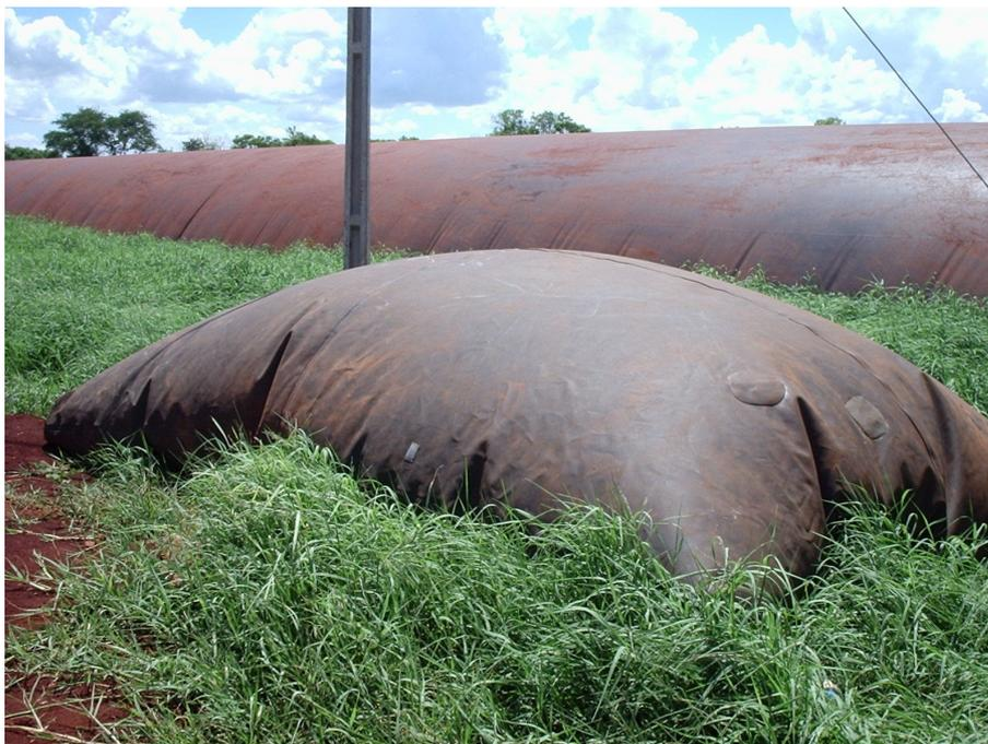
**Figura 10** - Gasômetro abastecido com biogás.
