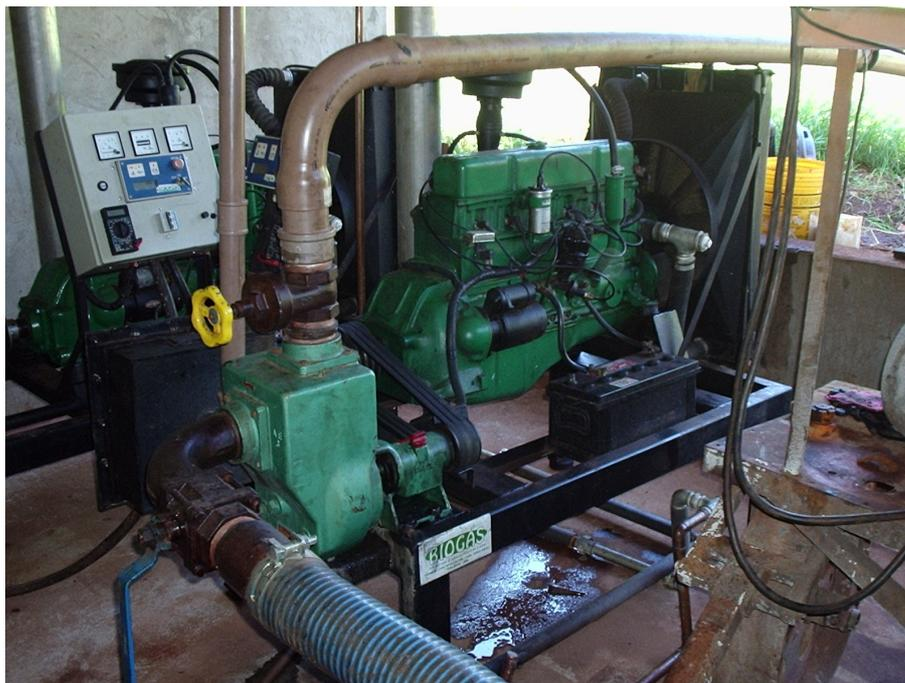
**Figura 7 -** Conjunto motor-bomba utilizado para irrigação na propriedade 2, operando com biogás da suinocultura.
