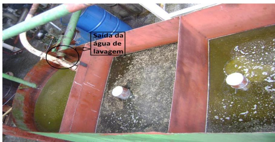
**Figura 7** Tanque de retenção de gordura.
