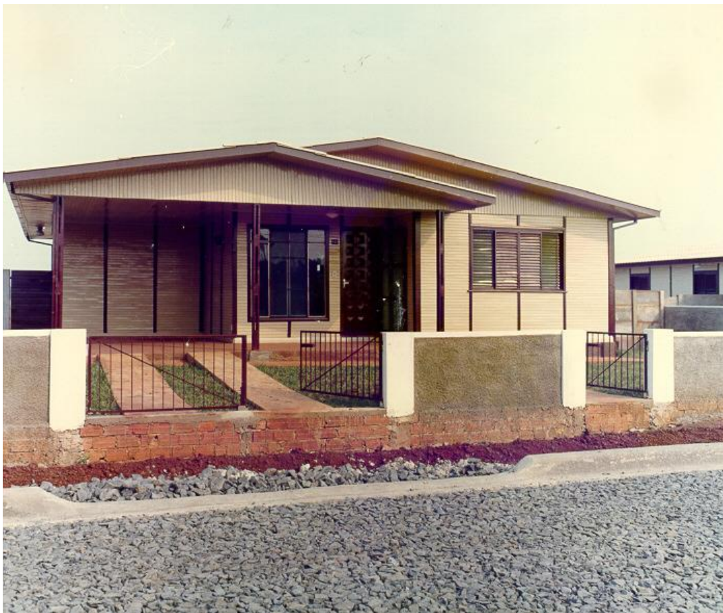
Foto 22: Casa de madeira na Vila “A”, anos 1980. Fonte: Acervo Itaipu Binacional.
